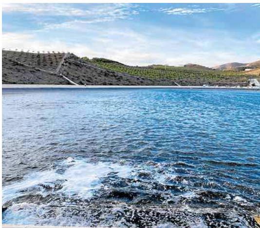
Balsa de aguas regeneradas de La Crujía en Vélez-Málaga. E. C.
