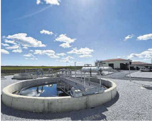
Saneamiento de La Cumbre.
